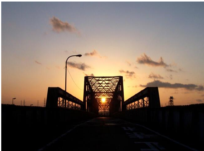
江ヶ崎跨線橋
